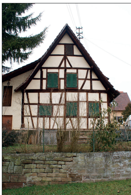
Südseite mit Dachgiebel
