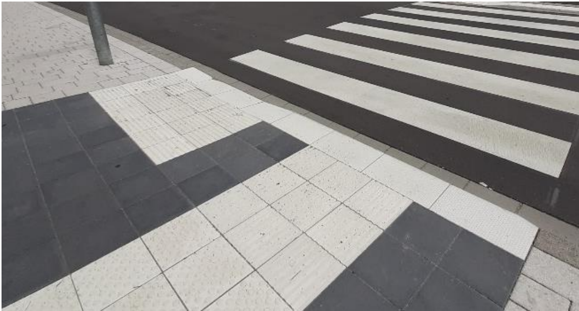
Abbildung 12: Beispiel für eine differenzierte Bordhöhe an einem Fußgängerüberweg
