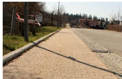
Abbildung 13: Beispiel für klare Leitkanten an einem Gehweg
