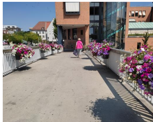
Abbildung 17: Einschränkungen durch Blumenkübel auf der B10-Brücke
