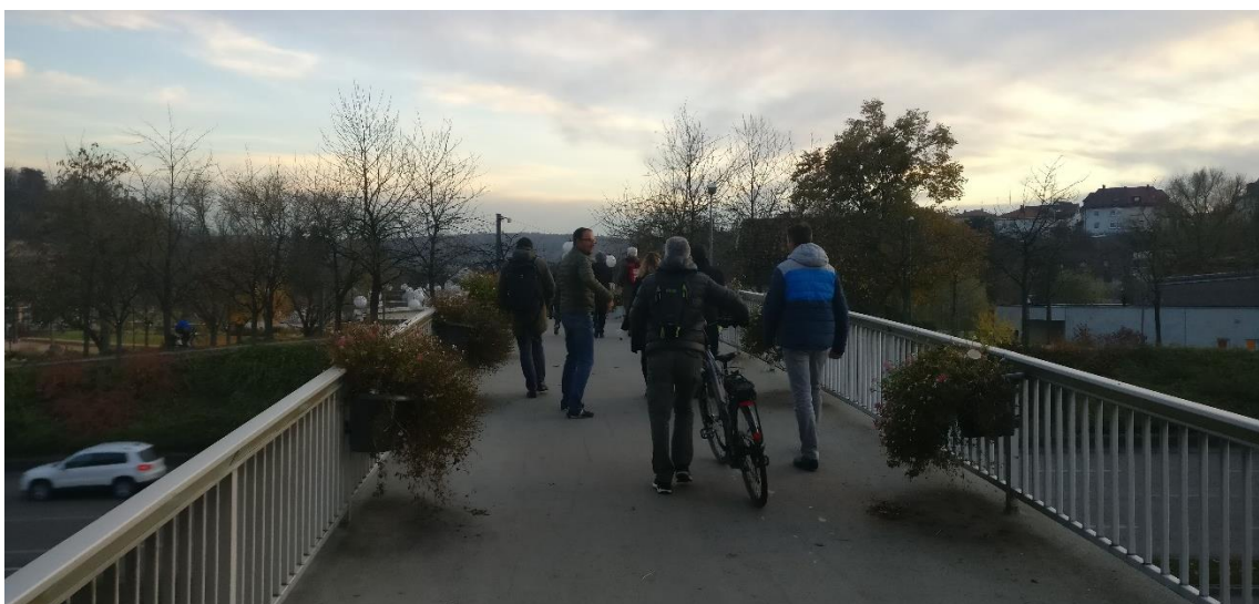
Abbildung 38: Einschränkung durch Blumenkästen auf der Brücke
