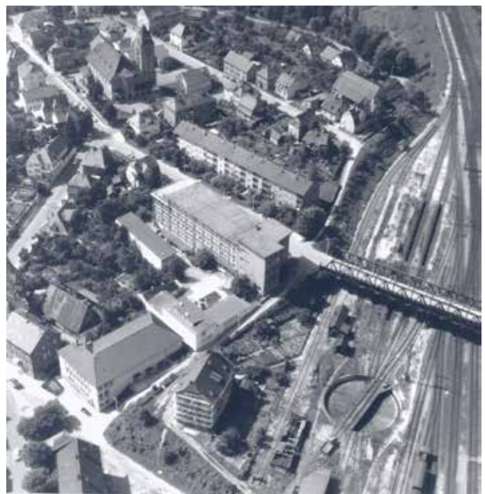
➡ Luftbild mit Kino Scala, Restaurant Bürgerhof sowie Drehscheibe und Eisenbahnbrücke (Luftbild-Verlag Bertram 1959, Stadtarchiv Mühlacker)
